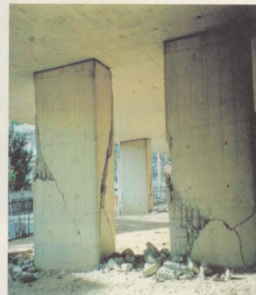
解説図-3.3.1 ひび割れのパターン (その 13)
