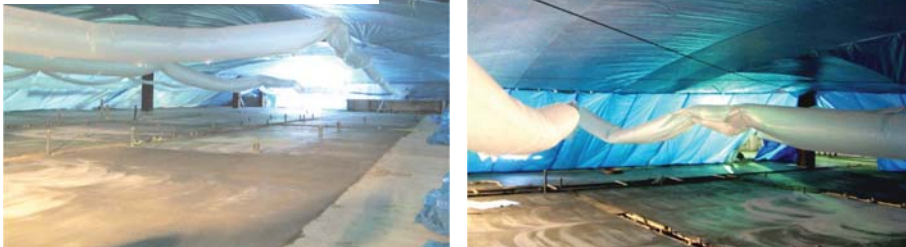
鉄骨にワイヤーを張りシートにて囲い、採暖(オイルファーンエス+ビニルダクト)。
