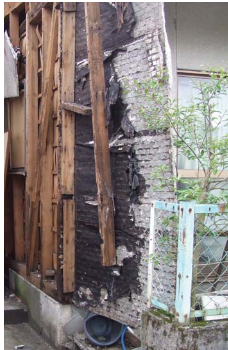
写真-3 木材の腐朽
