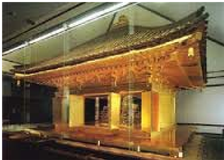
写真-24 中尊寺金色堂(新覆堂の中で更にガラスケースで 囲われ温度・湿度が管理されている)
