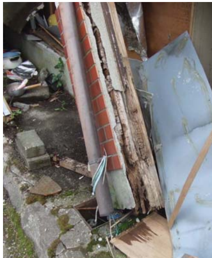
写真-3 木材の腐朽
