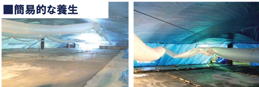
鉄骨にワイヤーを張りシートにて囲い、採暖(オイルファーンレス+ビニルダクト)。
