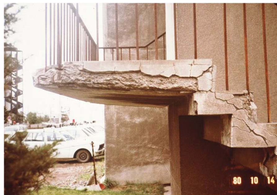
写真-12 外階段の凍害(裏側も融けた水が回り凍害が起きる)
