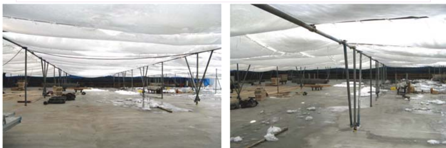
単管支柱にワイヤーを張りシートにて囲い、コンクリート打設時は採暖。
