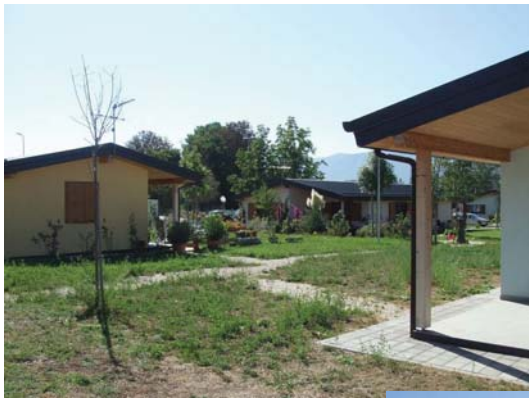
被災者のための住宅
