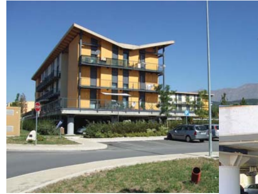
被災者のための免振住宅
