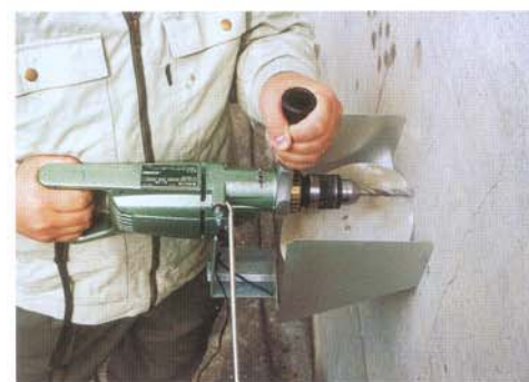
写真-4 ろ紙回転装置付きドリルを用いた技術者1名での試験
