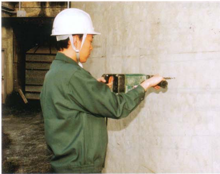
写真-1 ドリル削孔の状況
