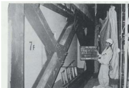
外壁ブレース補強工事
