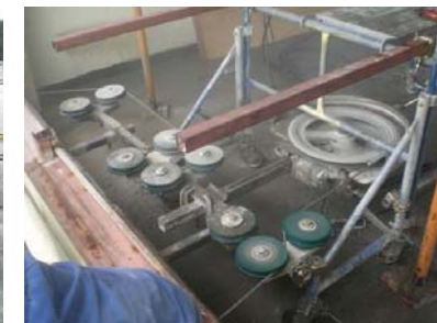
柱・梁を切断するダイヤモンドカッター
