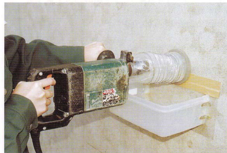
写真-1 ドリルによるコンクリート粉末の採取
