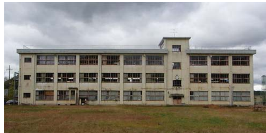
改修前 南面 全景
