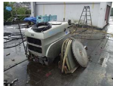
スラブを切断するコンクリートカッター
