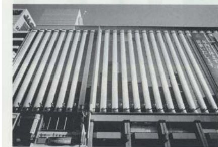
アルミカーテンウォール・熱線反射ガラスの外装
