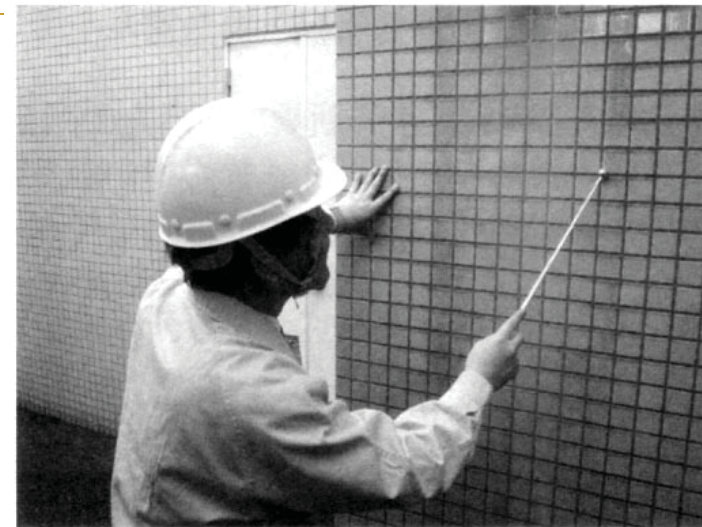
建築仕上診断技術者による タイル壁の打診検査
